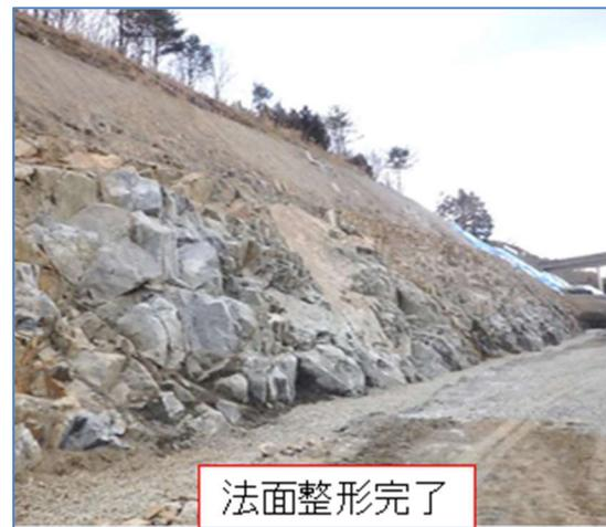
図 2-2-8 岩掘削後整形状況
