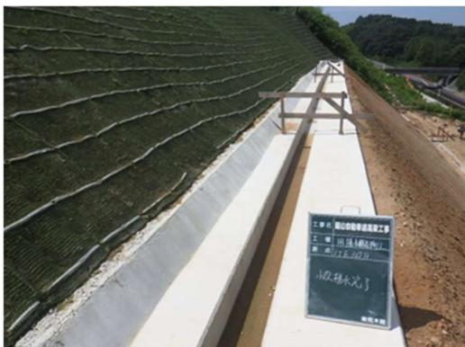
図 2-2-12 施工後の小段排水
