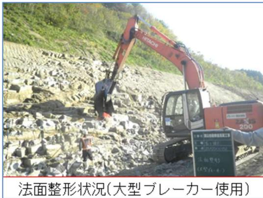
図 2-2-7 大型ブレイカーによる岩掘削状況
