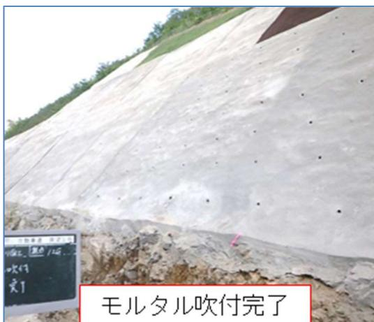
図 2-2-9 モルタル施工完了
