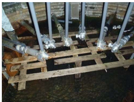
写真 5-1 集水管取付治具(左から①～⑥)
