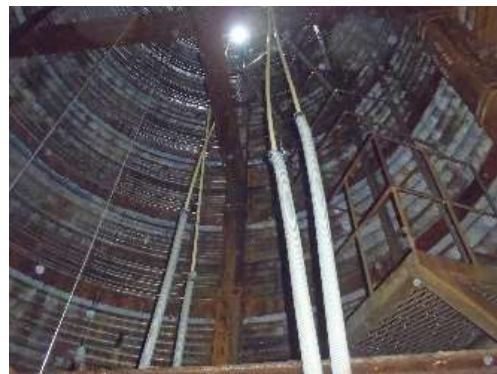
写真 6-9 外挿ホース上端(集水管②, ③, ⑤, ⑥)
