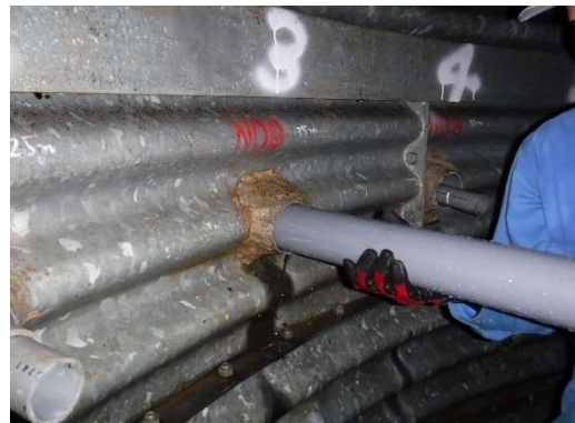
写真 4-3 VP40 による止水材押し込み状況
