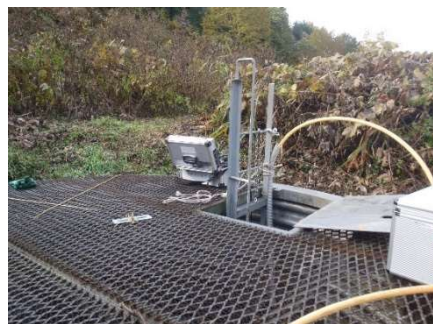
写真 5-2 給水車による⑥への水道水供給状況
