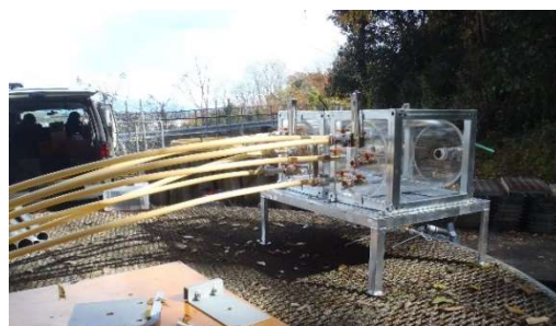
写真 6-4 上段(左), 下段(右)のヘッダー据付状況
