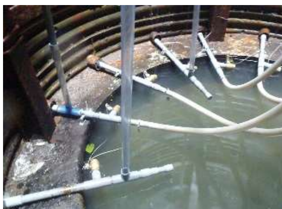
写真 6-8 集水管口元状況（左から①～⑥、①・④：閉塞管）とやや白濁した貯留水
