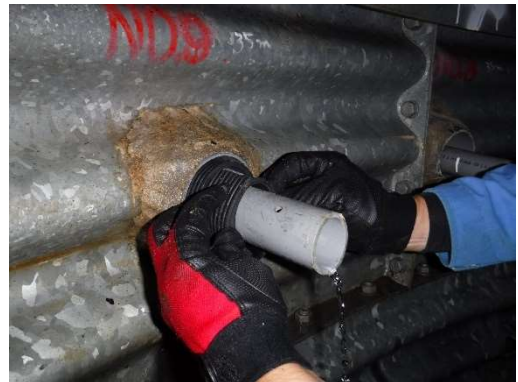
写真 4-2 膨張止水材巻付け状況
