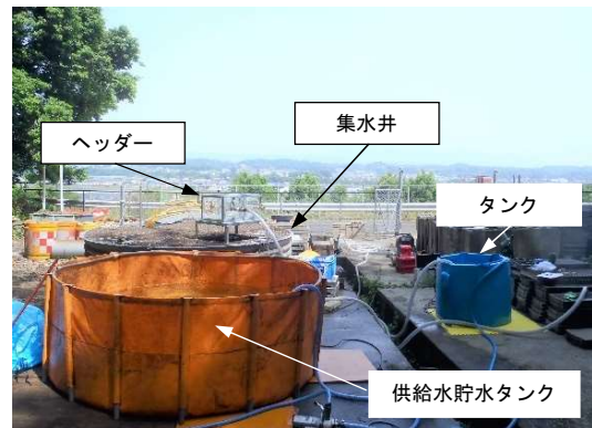
写真 4-1 「洗浄工」地上部装置配置例
