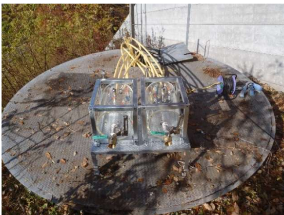
写真 6-1 上段（左）、下段（右）のヘッダー据付状況
