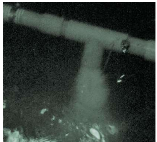
写真 6-12 脱離した EPS の排出状況
