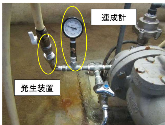
写真 8-2 発生装置と連成計
