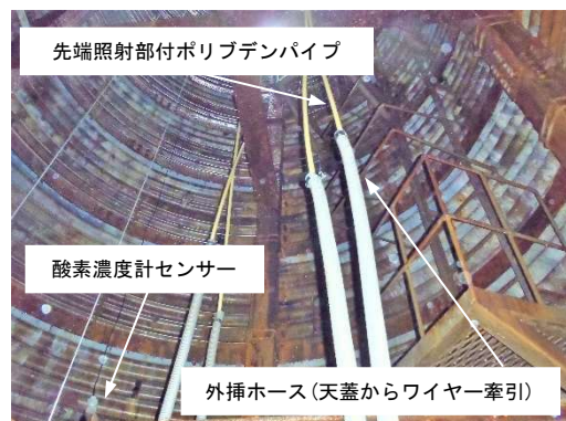
写真 4-5 ホース等ワイヤー牽引状況
