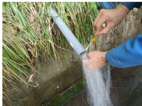
写真 4-10 排水管吐口での検水状況
