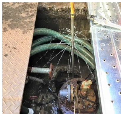
写真 8-1 井戸蓋と先端照射部
