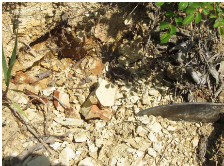
写真 12-1 無層理で堆積面沿いに剥離性がある。 (吉備高原都市吉川阿波良公民館裏の小法面露頭)
