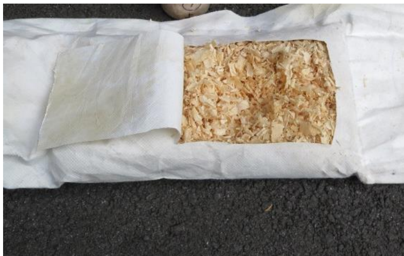
第3-3-7図 新規保護材の3年使用後の充填物（プレーナー屑）の様子
