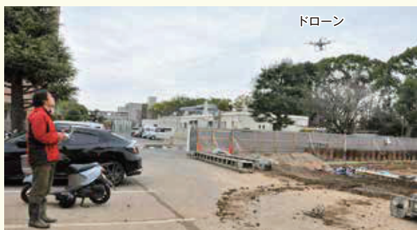
ドローンによる測量の様子
