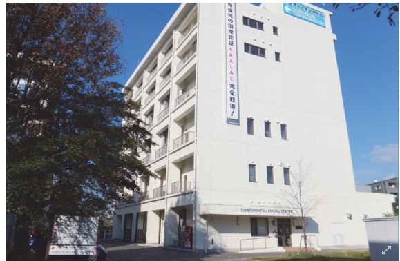
図1 総合動物実験施設(EAC)の外観
