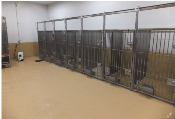
図6 自動給水システムを有するイヌ飼育室
