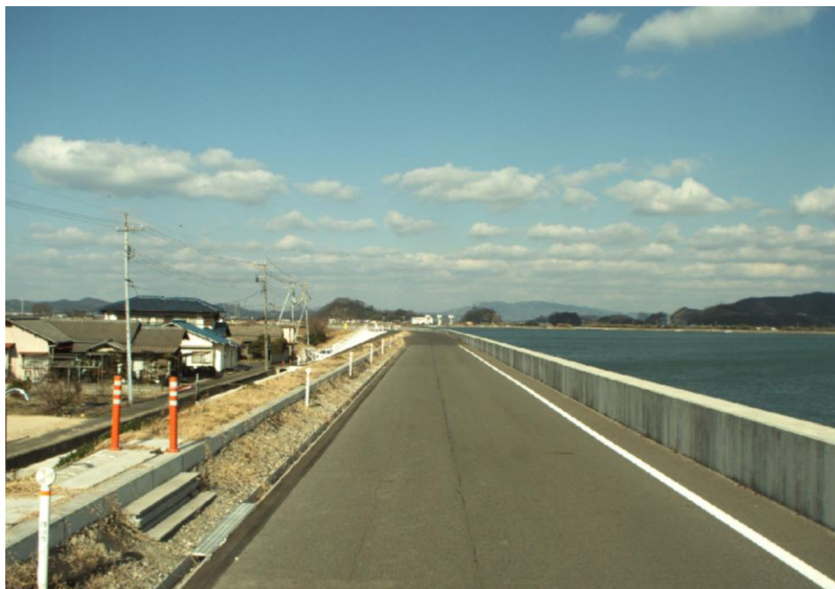
図 2-21 特殊堤付近の現況写真
