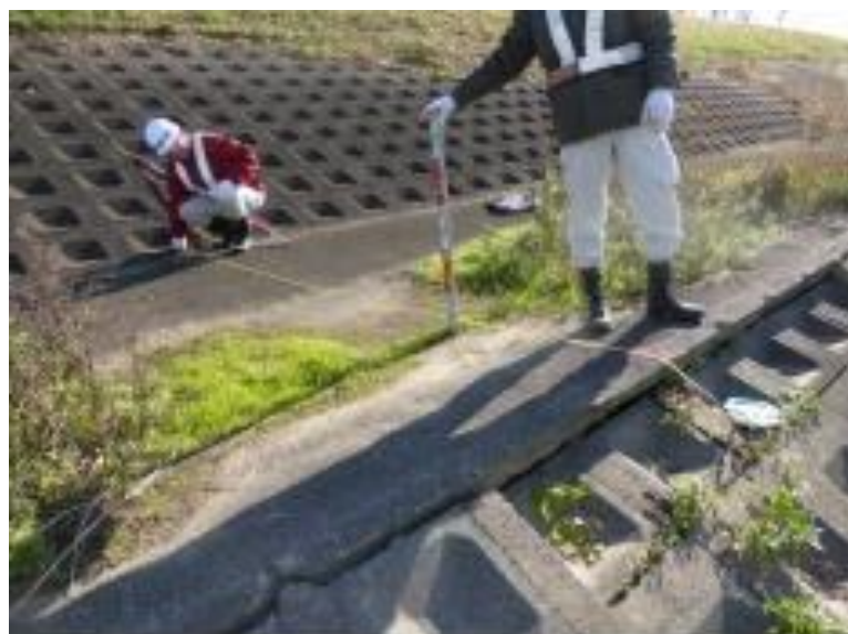
図 6-15 小段の逆勾配化箇所の状況
