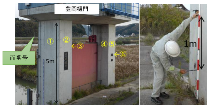
図 6-12 下げ振りによる傾倒計測風景
