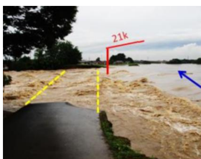
図 2-6 鬼怒川 決壊区間上流側からの写真 [国土交通省, 2016]
