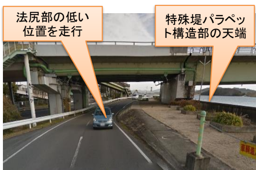
図 7-15 誤抽出したアンダーパス付近の現況写真
