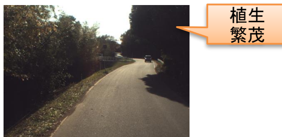
図 7-10 植生繁茂区間の現況写真
