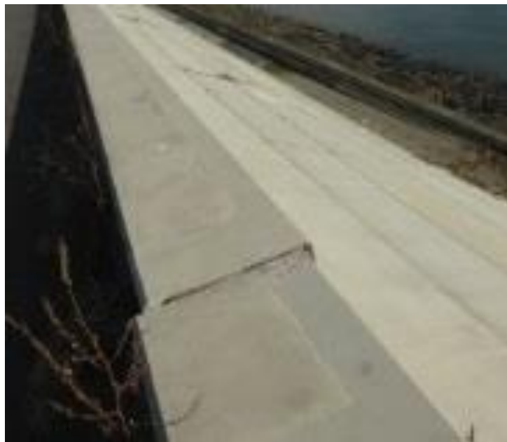
図 6-21 目地の開き確認箇所
