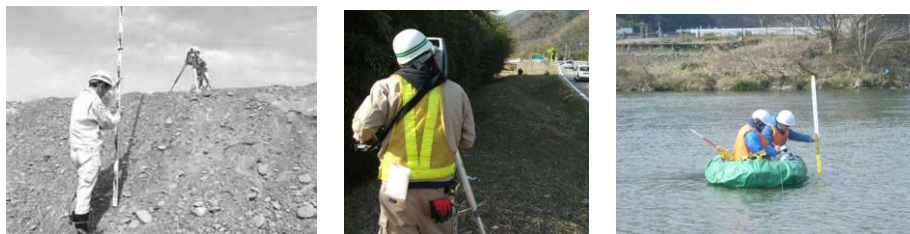
図 2-12 縦横断測量の現地計測風景
