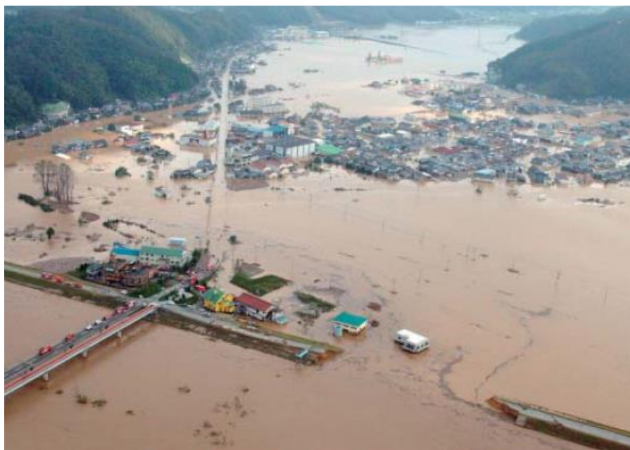
図 2-7 平成16年台風23号による円山川の破堤状況 [国土交通省, 2005]
