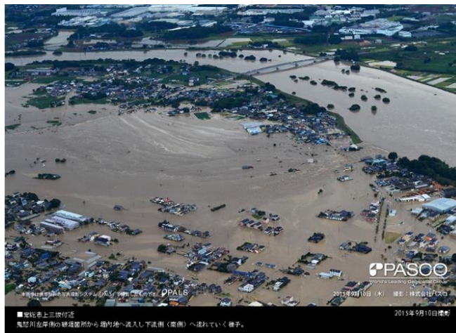
図 2-5 平成 27 年 9 月の関東・東北降雨による鬼怒川の破堤
