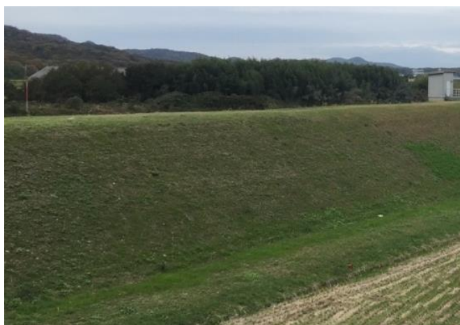
図 2-2 土堤 (兵庫県加古川)
