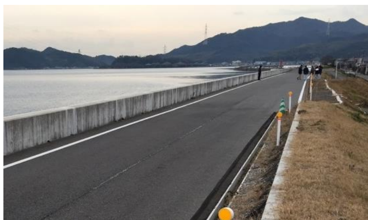
図 2-3 特殊堤 (岡山県吉井川)
