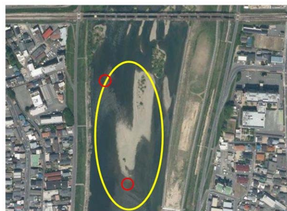
(d) 山陽本線鉄橋下の瀬(河口から約10km)
