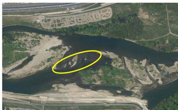
(b) 旭川中井堰の瀬(祇園地区)(河口から約16km)
