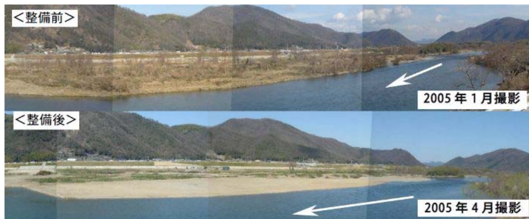
図 2.2 祇園試験区における礫河原の人工整備 5)
