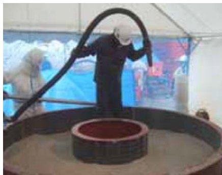
図 2.4-7 緩衝材の吹付け施工(文献 9)より引用)
