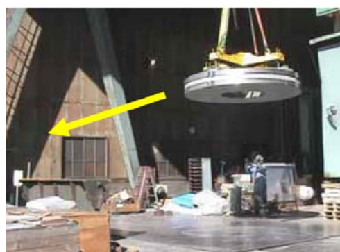
図 2.4-5 真空吸引装置による実規模緩衝材ブロックの移動試験（文献9）より引用）
