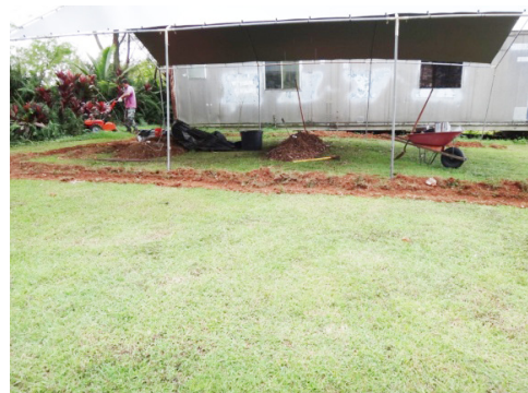
溝を作っているところ
