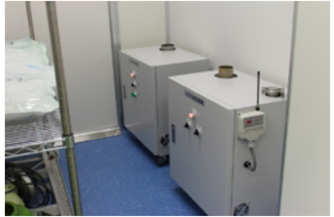
図 12 URM ガス消毒器
