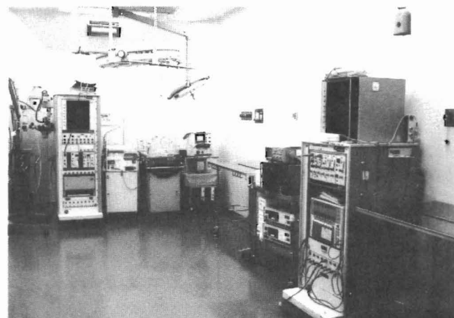
図9 移植手術室の内部である。ドナー、レシビエントを同時に操作できるように、手術台を二台同時に運用できる移植手術室が二室設備されている。天井からは毎時25回換気が行える清浄空気が垂直流をなして手術台を覆っている。このほかに同様の清浄空気が供給される2つの手術室がある。
