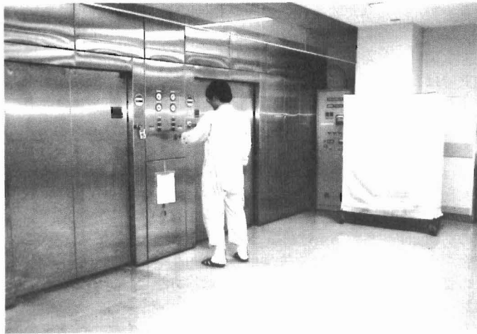
図3 施設には四機のフロアローディングのオートクレープが設備されている。すべての飼育機材は右に見える幌付き台車ごとオートクレープ滅菌された後、各飼育室へと運搬される。
