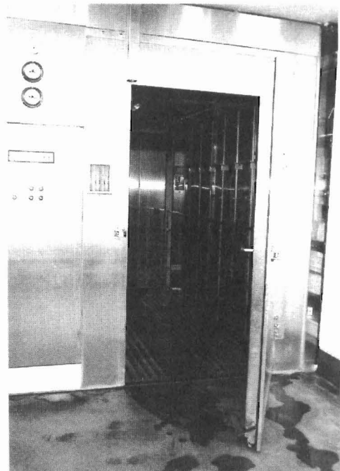
図4 米国NIHの基準によればラックは熱湯で定期的に洗浄しなければならない。このためラックワッシャーを設備した。90℃の熱湯で機材を洗浄可能である。
