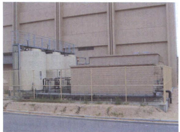
写真-5 建物外部の消毒・中和層、固液分離器および有機物処理プラント
