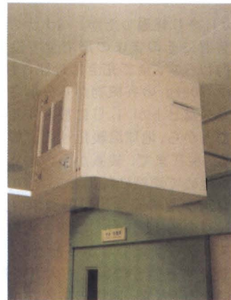
写真-4 空間噴霧装置
