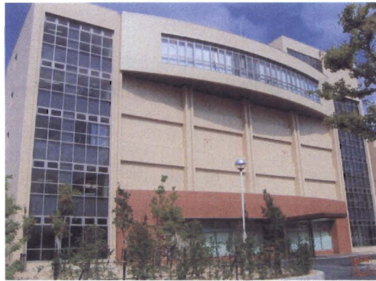
写真-2 動物生命科学研究センター新棟
