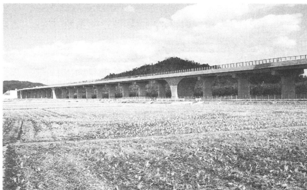
写真 3.2 総社高架橋の連続高架構造
