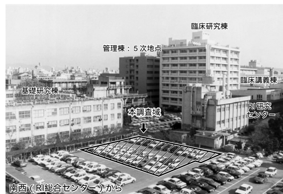
図7 調査地点遠景
