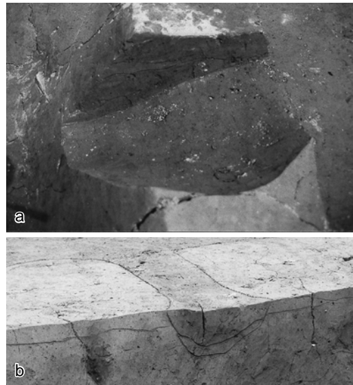
a. 水口1断面(南から) b. 水口4断面(北東から)
